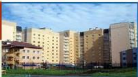
Многоэтажные дома из кирпича.
