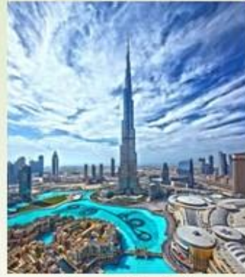
«Бурдж Дубай» («Дубайская башня»)
