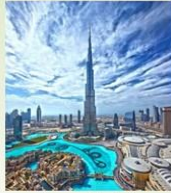
«Бурдж Дубай» («Дубайская башня»)
