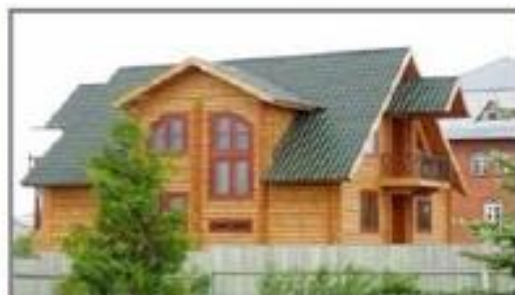
Деревянные частные дома.
