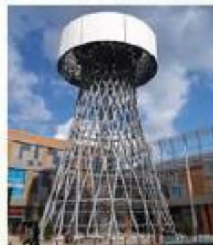
Сетчатая водонапорная башня по проекту В.Г. Шухова г. Краснодар
