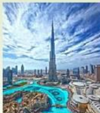
«Бурдж Дубай» («Дубайская башня»)
